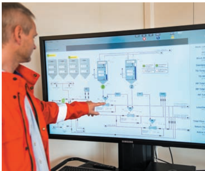
Локальный и удаленный мониторинг в режиме реального времени и логическое управление оборудованием для работы с буровыми растворами и завершенными системами.
